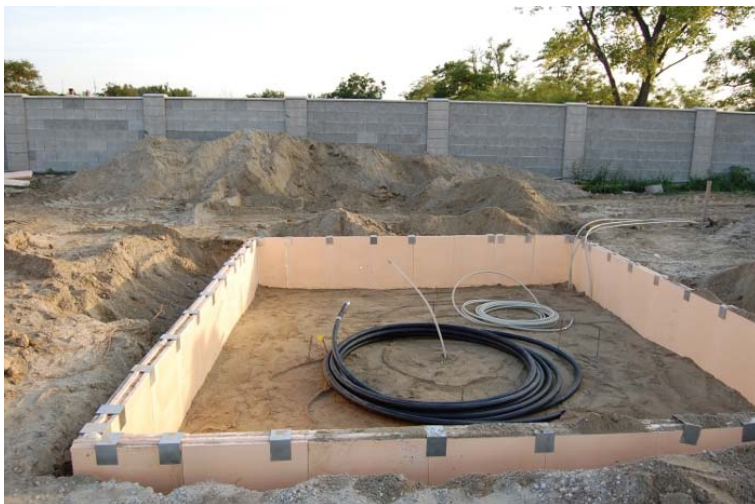
Abb. 4: Bau eines ® ISOMAX-Kernspeichers
