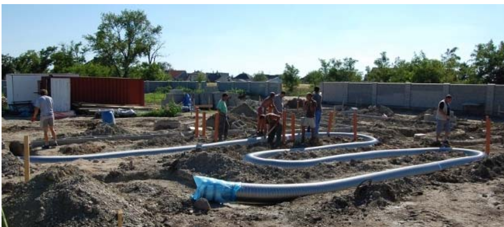
Abb. 11: Verlegung von ® ISOMAX-Rohr-in-Rohr-Luftwärmetauschern
