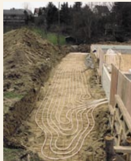
Chladiace okruhy zemného zásobníka tepla
