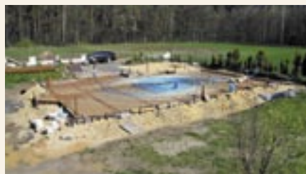
Potrubié ohrievajúce základovú dosku (teplé okruhy zemného zásobníka tepla)
