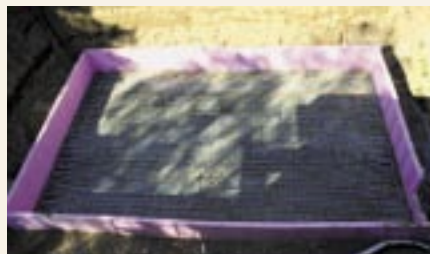
Výstavba jadrového zásobníka tepla
