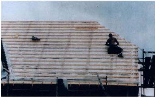
fig. 7.3. posa di tubi di assorbimento solare su lastra isolante del tetto
