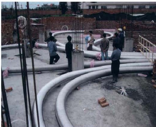
fig. 7.5. sistema controcorrente tubo-nel-tubo
