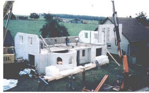
fig. 7.4. montaggio di grandi elementi per pareti con tubazioni integrate
