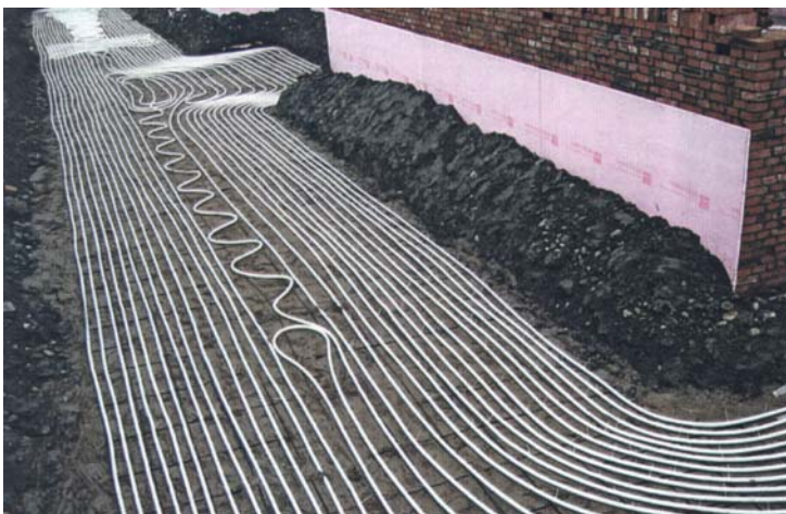
fig. 7.2. conduttori del circuito di raffreddamento posati accanto a un edificio
